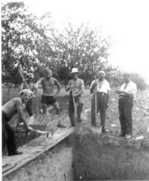
Baugrube im Randweg
