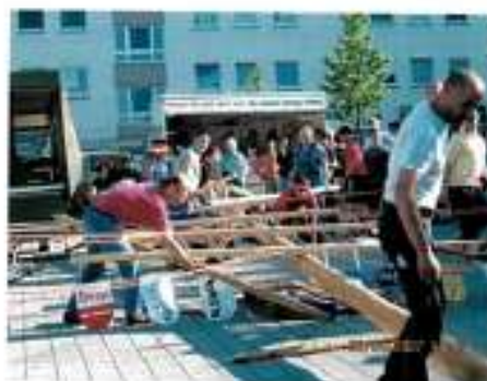
Vorbereitung zum aufstellen
