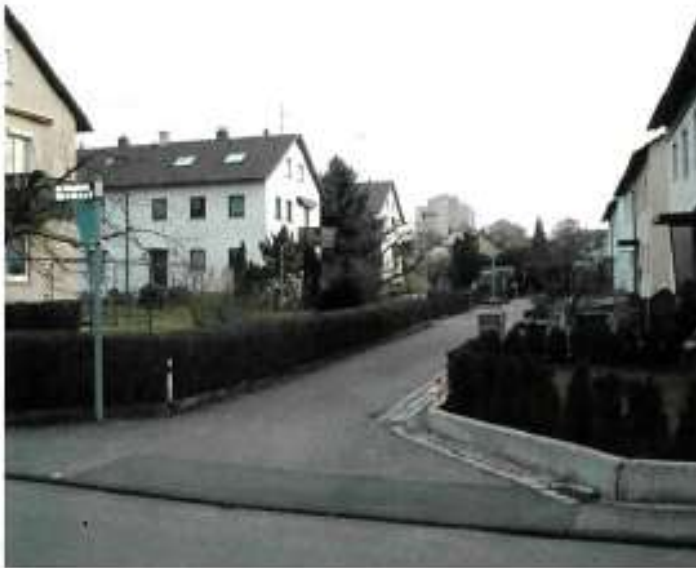
Die TWS-Häuser von der Schmollerstrasse gesehen
