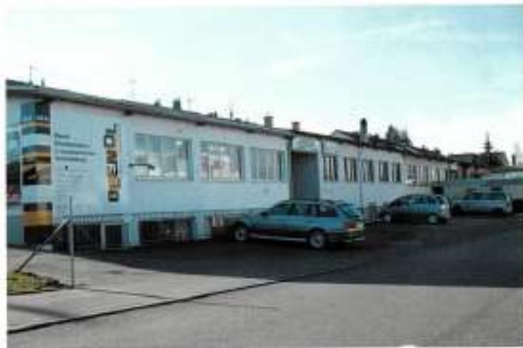
Das Handwerkerviertel von der Steinhaldenstrasse her gesehen
