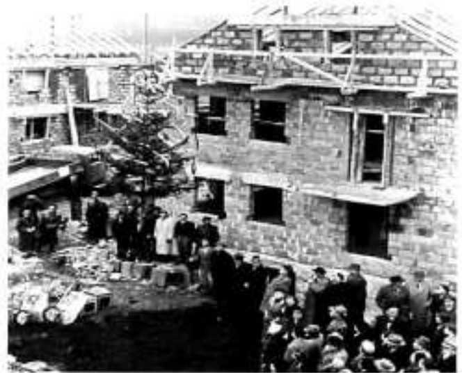
Richtfest am Neubau der TWS-Siedlung
